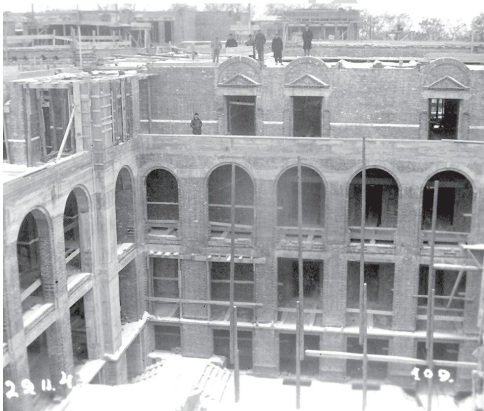
13. A központi épület építése (1929. február)
